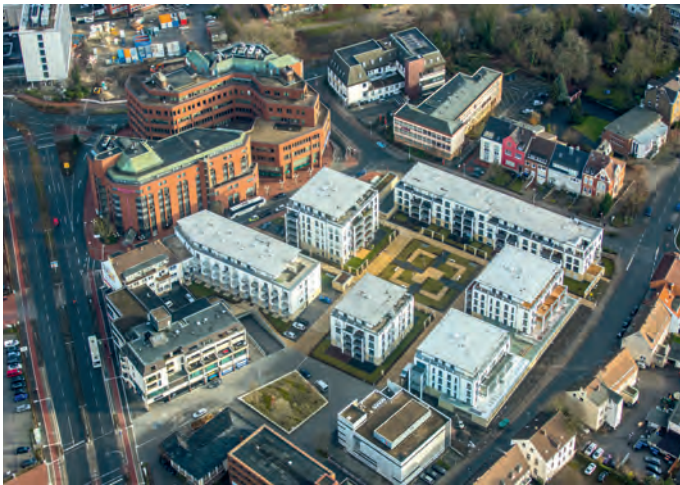
Hamm 2017: Das neue Museumsquartier ist fertiggestellt (Foto: Hans Blossy)
