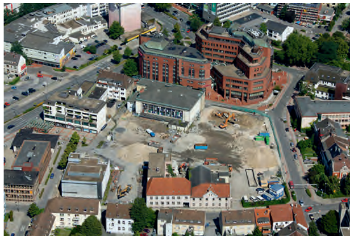
Hamm 2010: Baustelle auf dem ehemaligen Gaswerksgelände (Foto: Hans Blossey)
