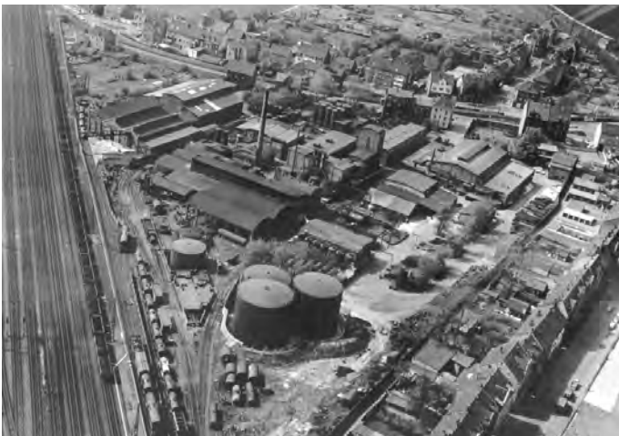
Raschig 1967: Die Dachpappenfabrik um 1967 (Foto: Stadt Bochum)
