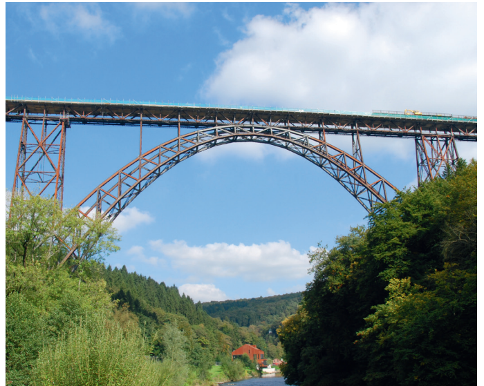
Müngstener Brücke (Foto: Stadt Solingen)
